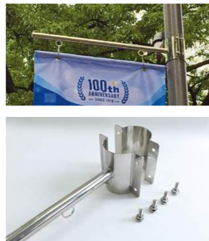
既存の街路灯に合わせたオリジナルのアームを制作・施工
